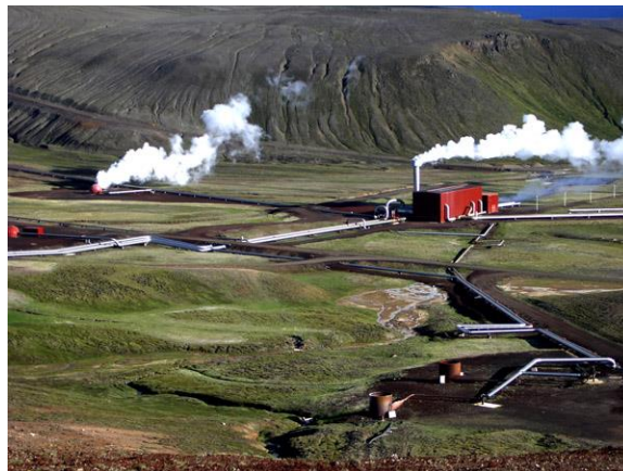
Rys. 25 ELEKTROWNIA GEOTERMALNA KRAFLA (ISLANDIA)
