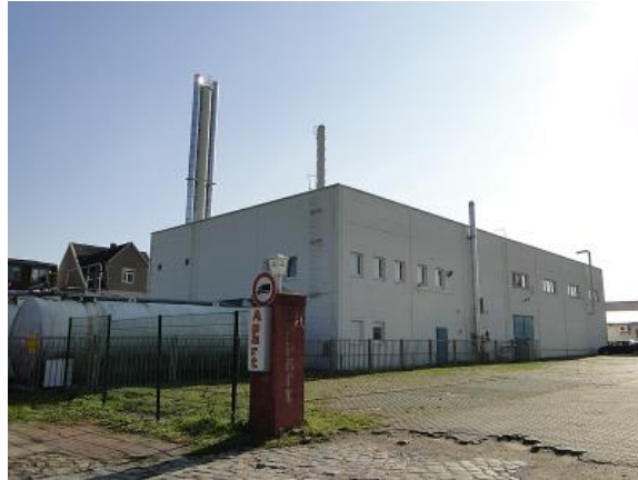
Rys. 24 GEOTHERMISCHE HEIZZENTRALE NEUBRANDENBURG
