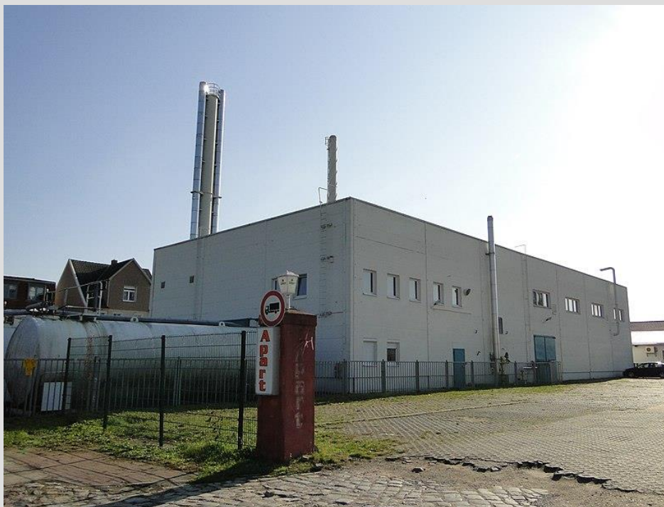
GEOTHERMISCHE HEIZZENTRALE NEUBRANDENBURG
