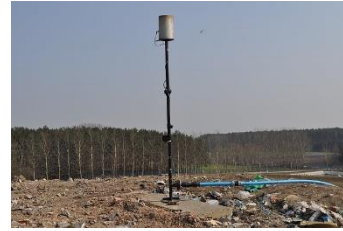
Odgazowanie składowiska śmieci
