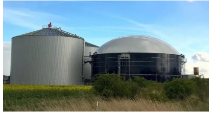
Biogazownia ze świńskiej gnojowicy
