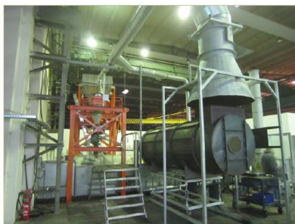
Rys. 16 Zakład pirolitycznego rozkładu odpadów MEE-Anlage Schwerin (Niemcy)
