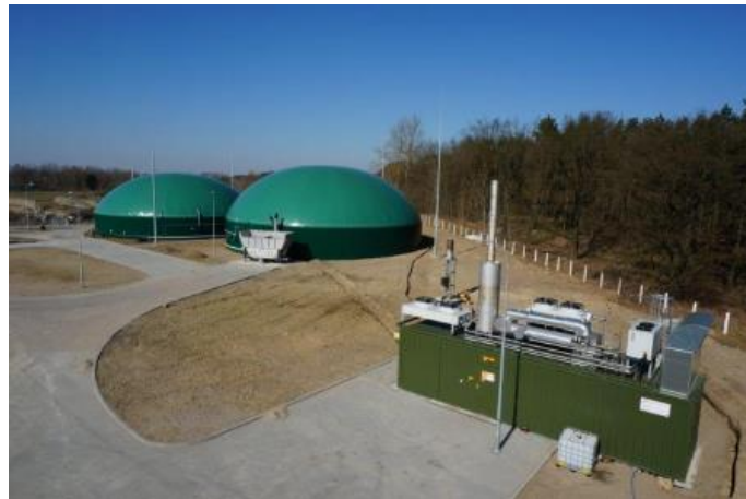
Rys. 22 Biogazownia rolnicza Brzeżno (woj. zachodniopomorskie)
