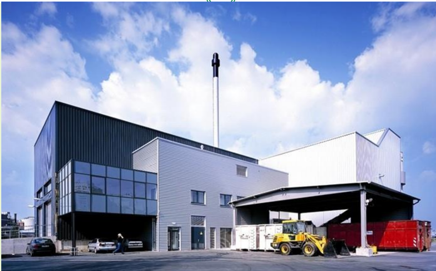
Zakład pirolitycznego rozkładu odpadów komunalnych Minden (Niemcy)
