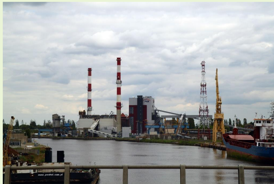
Elektrociepłownia Szczecin (PGE Energia Ciepła S.A) z największym w Polsce kotłem na biomasę https://pgeenergiaciepla.pl/spolki-i-oddzialy/elektrocieplownie/pge-energia-ciepla-oddzial-w-szczecinie
