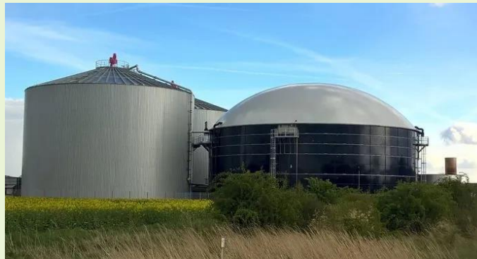
Biogazownia ze świńskiej gnojowicy
